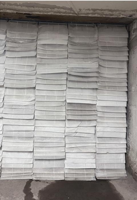
Beispiel für einen kapitalen Wartungsfehler - die Taschenfilter wurden "liegend" eingesetzt und haben Kontakt zu Kondenswasser. Die Filterwand ist energetisch und in Bezug auf die Filterleistung ineffizient. Zudem droht ein Hygieneproblem, da einzelne Filtertaschen kontakt zu Feuchte haben. Dies begünstigt Keimwachstum in den Filtern.
