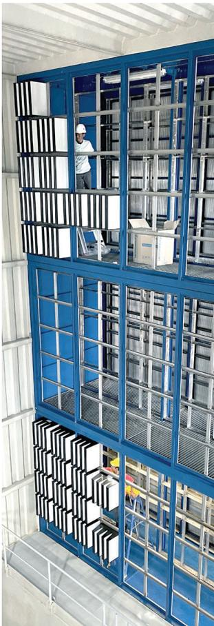
Filterwechsel bei einer Gasturbine in Bangkok, Thailand. Je Turbine werden bei der Hauptfilterstufe dieser Anlage je 540 Luftfilter vom Typ HS-Deka Pak GT der Klasse ISO 29463:T9 eingesetzt.
