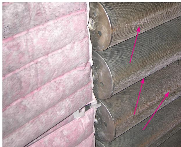
*Fibreshedding von Glasfaserfiltern ist nicht immer so deutlich an nachfolgenden Filterstufen und Bauteilen sichtbar wie in diesem Beispiel.*
